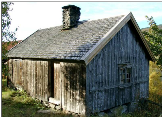
Figur 5. På Skorilla står et nyrestaurert uthus som tidligere har fungert som mastu og smie. Huset har spontak og er en av få bygninger hvor denne tradisjonelle taktypen er beholdt.
