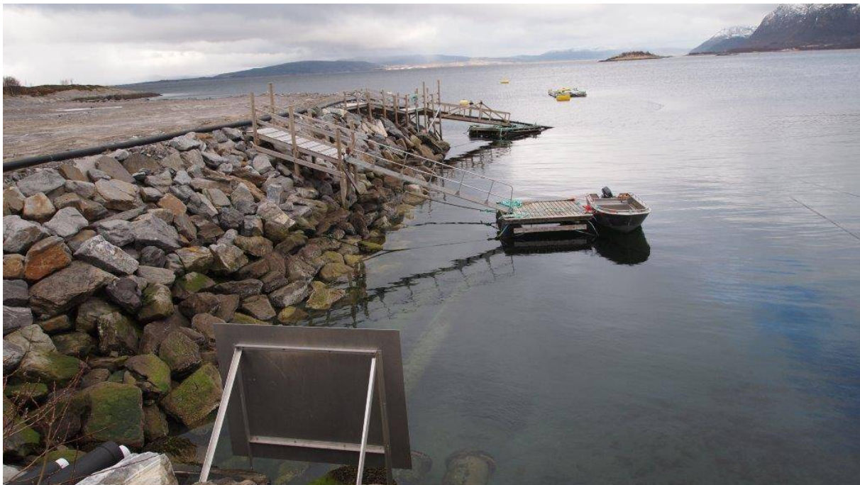
Figur 1. Utslippsledningen ut fra anlegget. Det var ikke synlig gjennomslag til overflaten.
