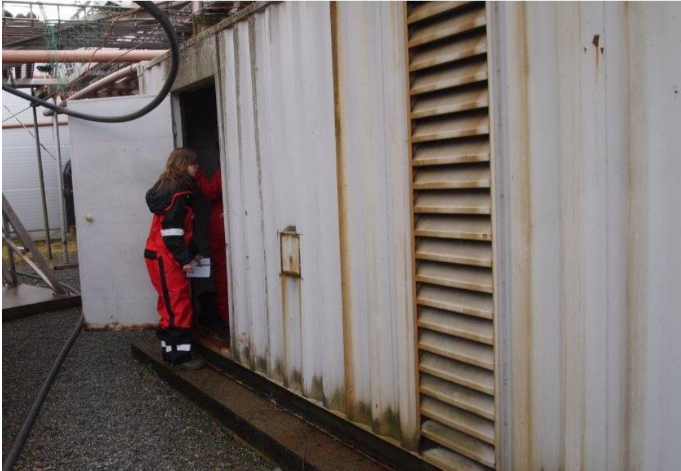
Figur 2. Gammelt aggregat som er i ferd med å byttes ut.
