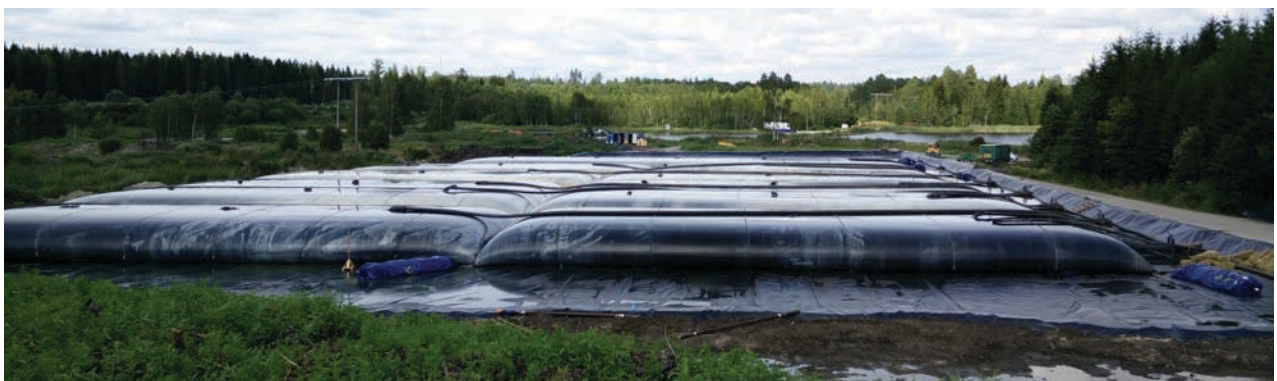
Figur 1-3. Eksempel på oppfylling av det første laget med Geotuber. Det avvannes her forurensede sedimenter (kilde: Sito OY).
