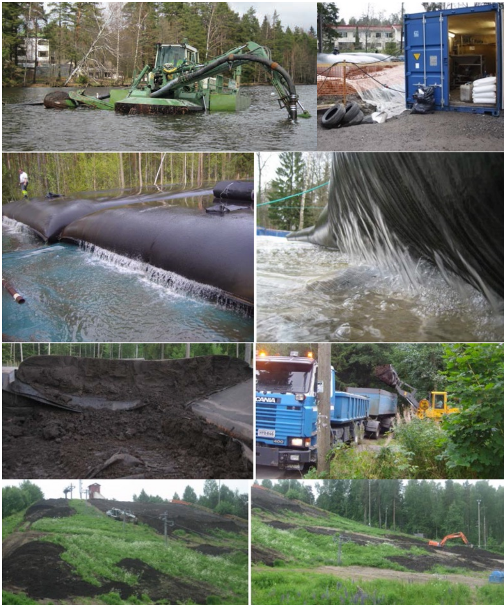
Figur 1-2. Bildene viser eksempel på sugemudring av organiske innsjøsedimenter. Det er vist eksempel på mudringsenheter, doseringsenhet, avvanning fra Geotuber, ferdig avvannet organisk sediment og gjenbruk i et skianlegg (Kilde: Sito OY).
