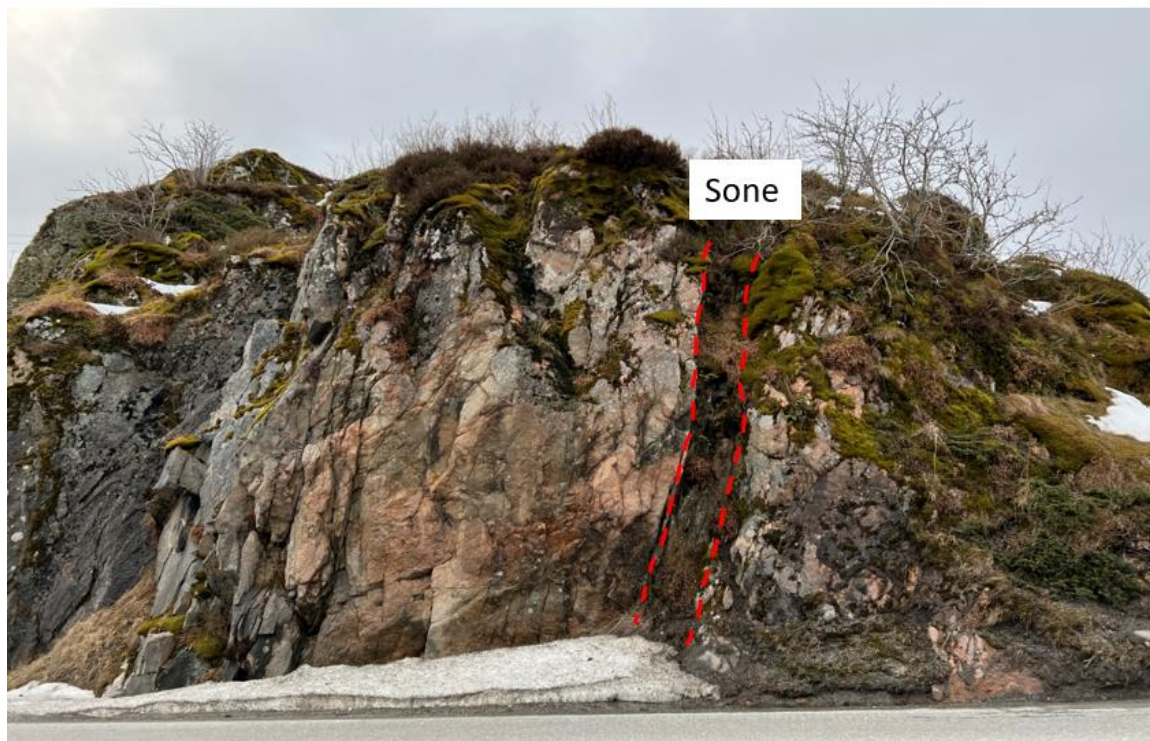
Figur 46: Bergskjæring ved profil 1210-1240, venstre side. Oppknust sone (<0,5 m) ved 1230-35.
