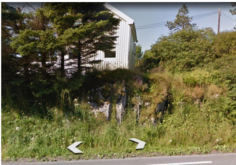
Figur 41: Ca. profil 580, sett mot vest. Hjørnet av bolighus kommer tett inntil bergskjæring. Sprekkesett S1 er tydelig i bergblotningen (google earth).
