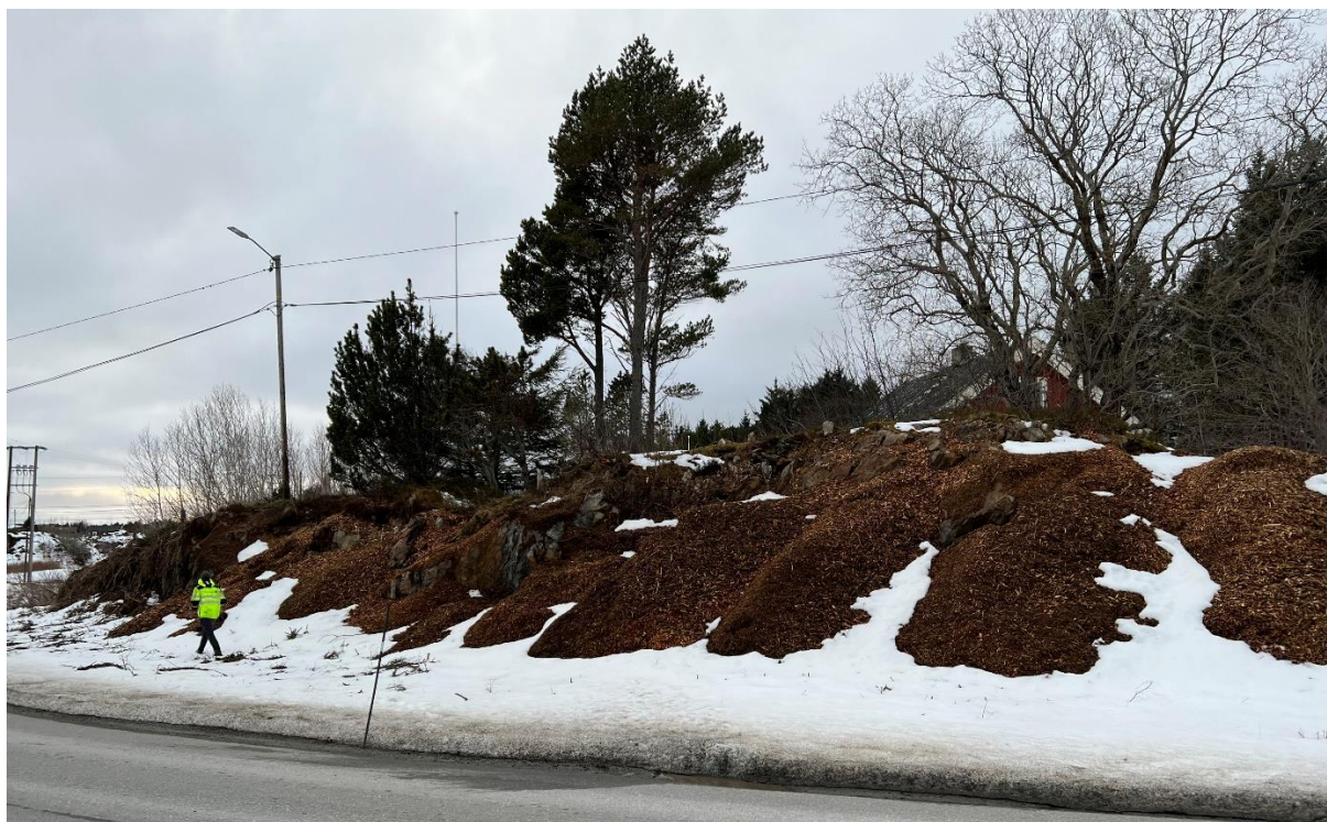
Figur 11: Eksisterende bergskjæring, profil 1470-1530, venstre side.
