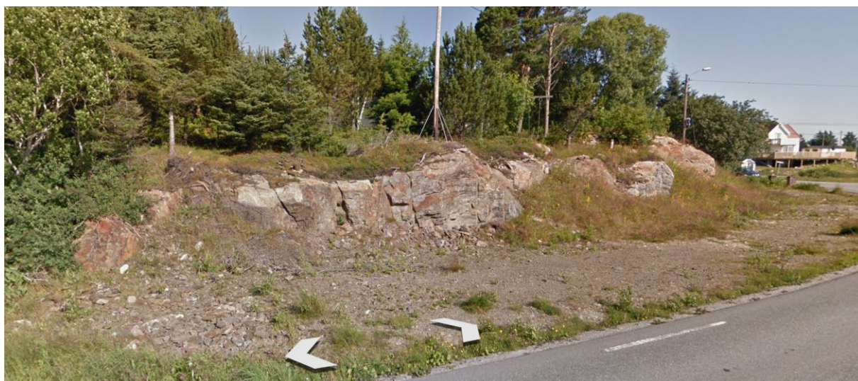
Figur 12 : Eksisterende bergskjæring, profil 1470-1530, venstre side. Bilde fra google earth.
