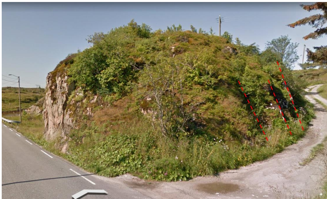
Figur 47: Profil 1210-1240, venstre side sett mot sørvest. Stiplede linjer antyder forsenkninger, trolig i samme retning som sprekesett S2.
