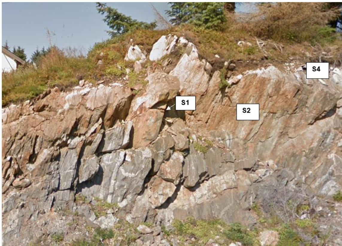
Figur 19: Opptredende sprekkesett i eksisterende bergskjæring ved profil 1710-1800, venstre side. (google earth).
