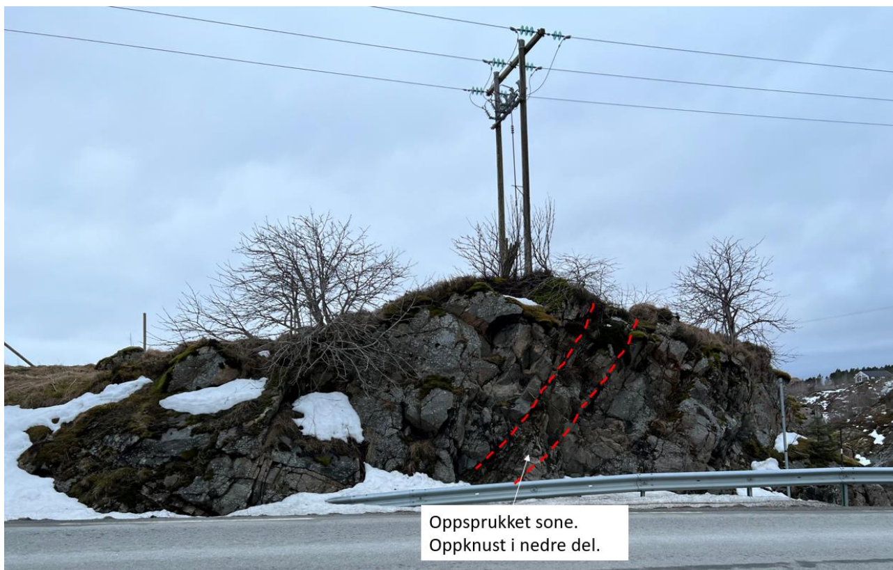
Figur 45: Profil 1100-1120 venstre side. Høyspentmast på topp skjæring.
