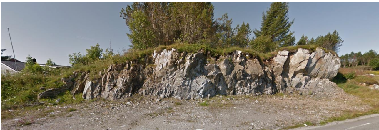
Figur 28: Oversikt av eksisterende bergskjæring ved profil 280-340, venstre side (google earth).
