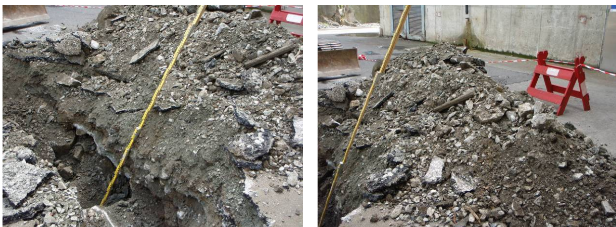
Figur 9: PG 9 er avsluttet i dybde 1,3 m mot antatt steinblokk. Løsmassene bestod av steinfylling med rester av rivemasser.
