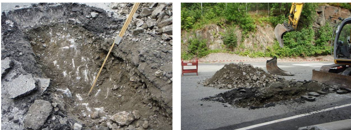
Figur 6: PG 6 er avsluttet mot antatt utsprengt berg.
