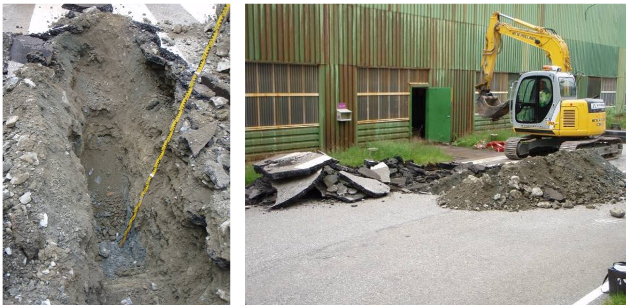
Figur 7: I PG 7 var det flere tykke asfaltdekker. Prøvegropen er avsluttet ca. 0,3 m ned i antatt morene.
