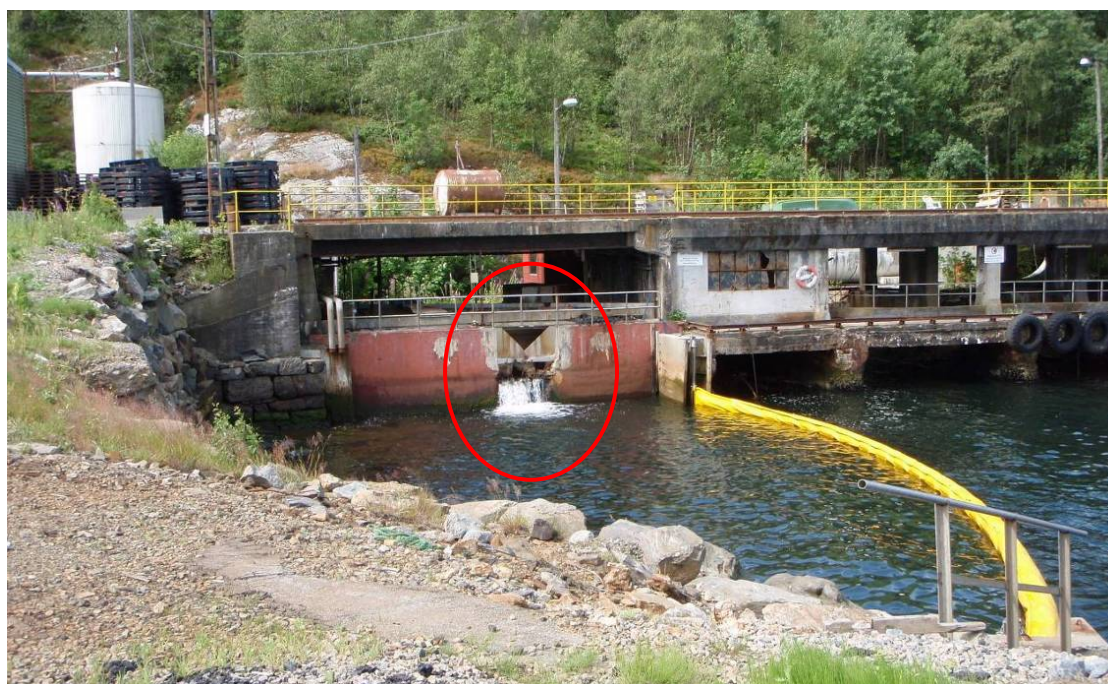
Figur 2: Bilde som viser utløpet av bekken i Simonsviken. Bildet er tatt mot vest.
