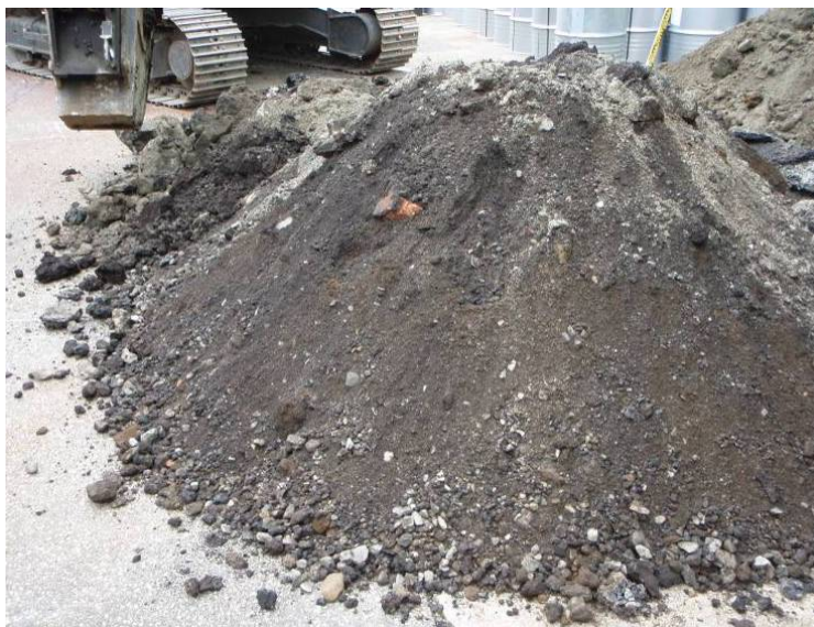
Figur 13: I PG 13 ble det funnet fyllmasser av produksjonsavfall (aske og slagg). Graving ble avsluttet i fyllmasser 2,6-2,7 m under terreng.
