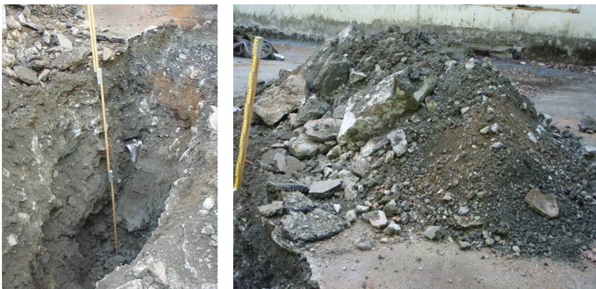
Figur 4: PG 4 ved det nordvestre hjørnet av bygget ble avsluttet i antatt morene.
