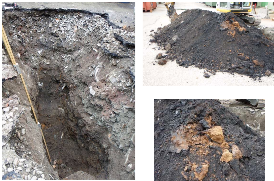
Figur 8: Bildet til venstre viser løsmassene i PG 11 mens bildene til høyre er tatt av oppgravde masser fra PG 14.
