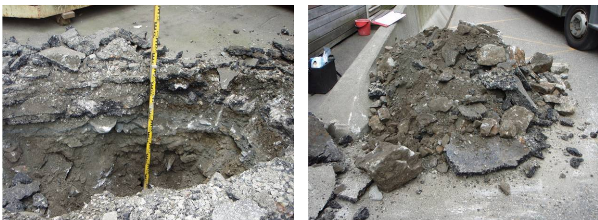
Figur 8: I PG 8 var det flere lag med tykke asfaltdekker. Graving er avsluttet mot antatt steinblokk.
