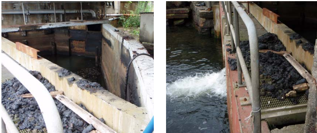
Figur 3: Ved utløpet av bekken i Simonsviken er det en oljeutskiller. Over tid samles det her opp en del klumper av olje som kommer med bekkevannet.
