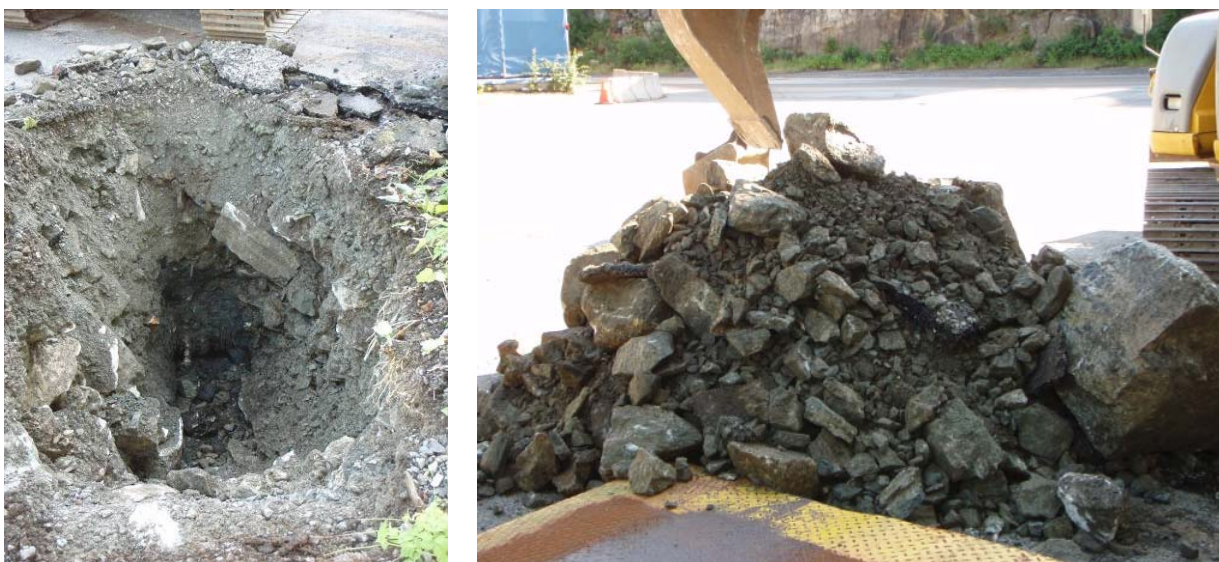
Figur 5: PG 5 ved den nordre kortveggen av fabrikkbygningen ble avsluttet ca. 0,3 m ned i antatt stedlige masser av morene.
