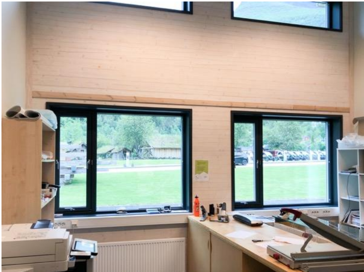
Skjøter på yttervegg, dekket over med en gulvlist. Norsk Fjordsenter. Foto: Dag Strass
