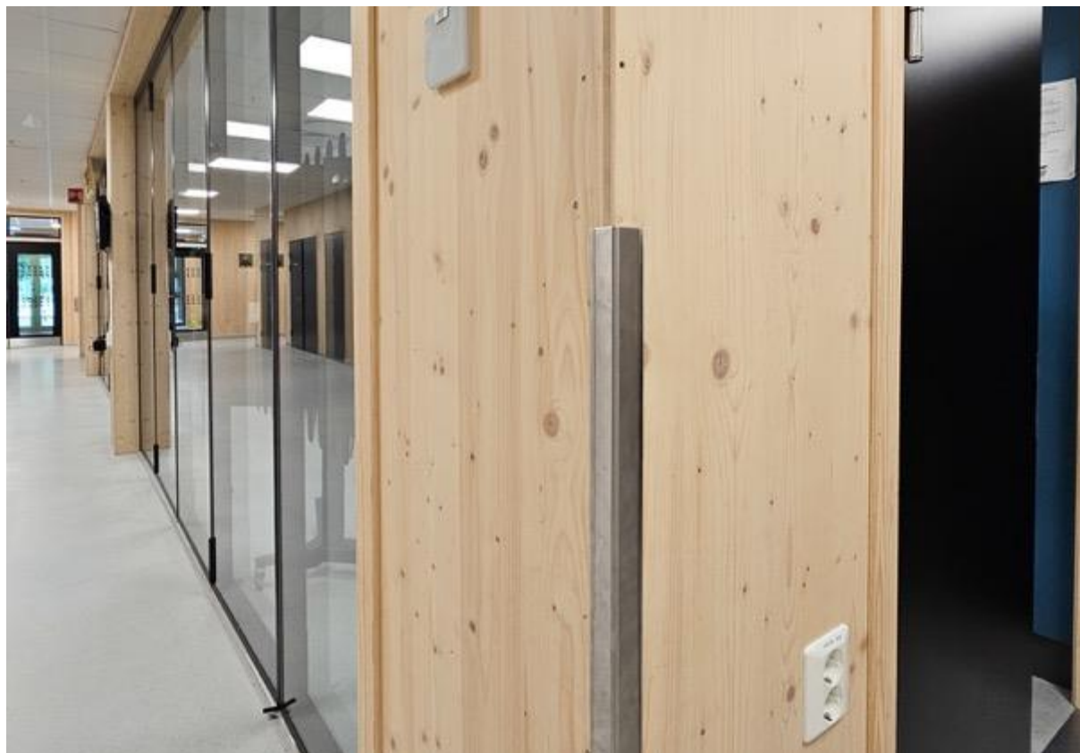
Massivtreplater lagt utenpå gipsplater. Sæbø skule og barnehage. Foto: Knut Werner Lindeberg Alsén
