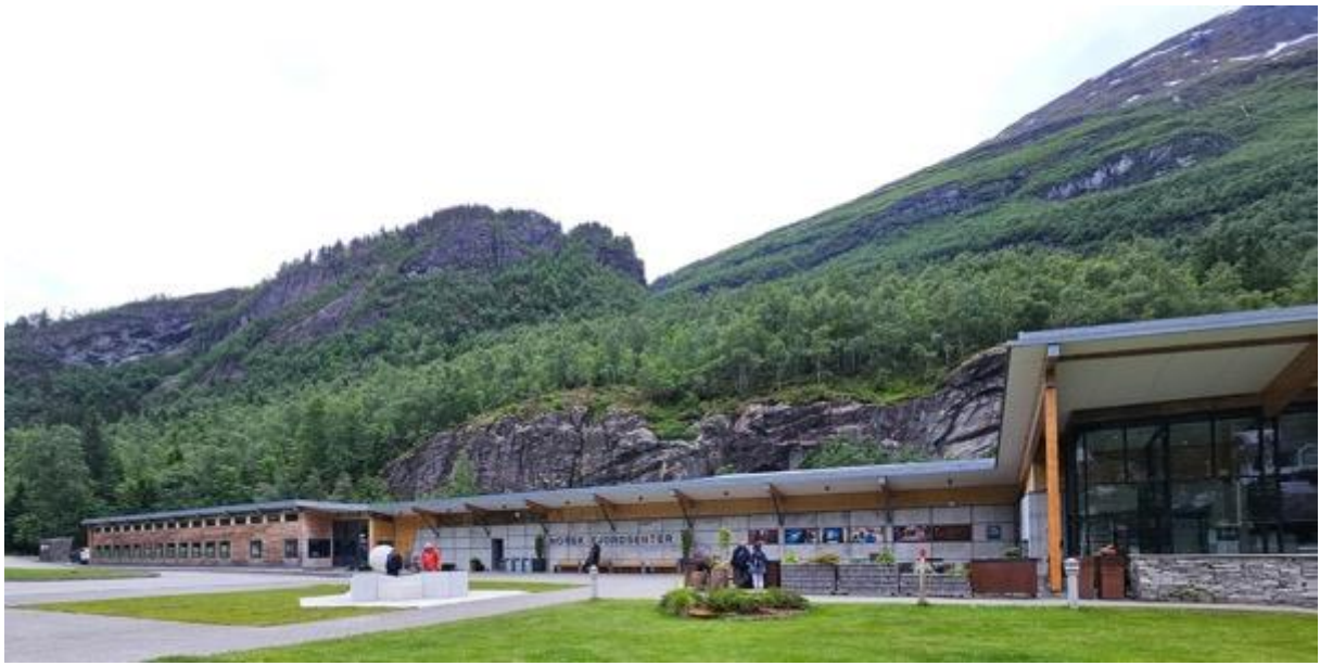
Tilbygg til Norsk Fjordsenter. Foto: Knut Werner Lindeberg Alsén
