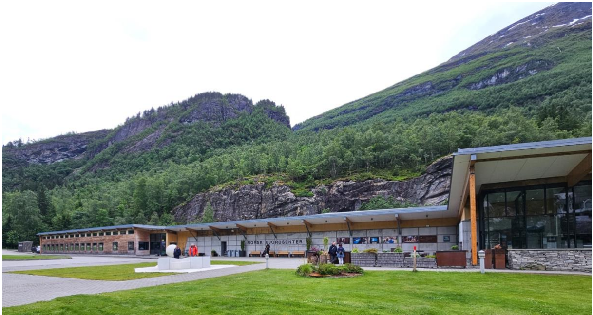
Tilbygg til Norsk Fjordsenter. Foto: Knut Werner Lindeberg Alsén
