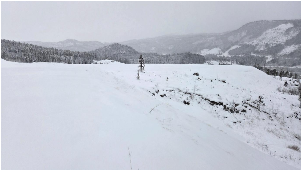
Figur 19: I bildets forgrunn sees naboeiendommens fylling, i bakgrunnen sees fyllingen på aktuell eiendom. Bildet er tatt mot sørvest under befarig, 07.01.2026.
