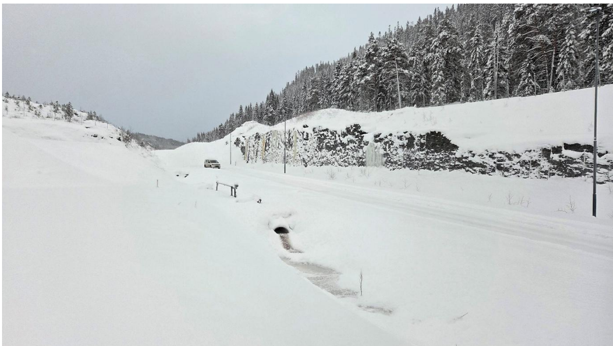
Figur 24: Aktuell eiendom med Lekåsveien og innkjøring til næringsområdet. Rødbekken som er lagt i rør sees i veigrøfta. Bildet er tatt mot sørøst under befarig, 07.01.2026.
