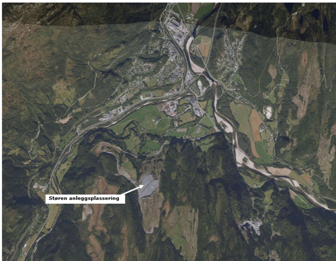
Figur 1: Flyfoto som viser anleggsplassering. Kilde: Norge i bilder Trøndelag 2022, utsnitt tatt 16.03.2026
