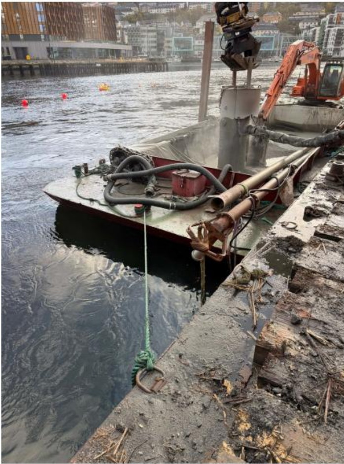
Figur 10-1 RC-boring med sykron, der returmateriale ledes til splittlekter for oppsamling og sedimentering (Bilde fra Geo Fundamentering og Bergboring AS).
