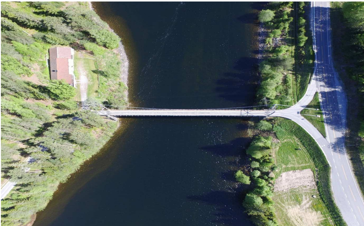
Bilde 2 og 3. Dronebilder av Ose bro sett fra nedstrøms side (øverst og nederst). Bildene ble tatt den 31.05.2017.
