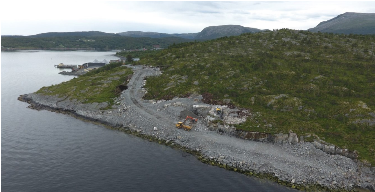
Figur 1-1: Dronebilde tatt av planområdet i 2023. Bilde viser anleggsveien.
