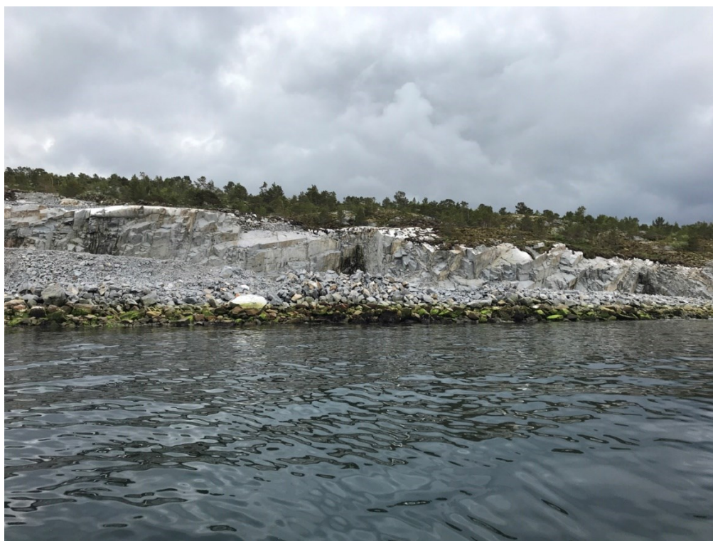
Figur 3-7. Modifisert hardbunn av sprengstein i strandsonen øst i utredningsområdet.
