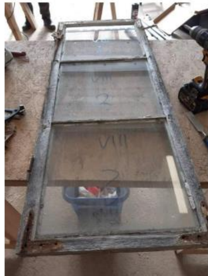
Beslag og hengsler vart plukka av for reingjering .og innsett med 2 strøk Owatrol antirust.
