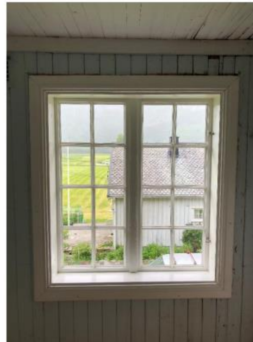
Ny restaurert vindauge på plass.
