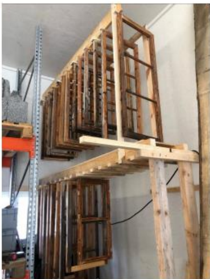
Etter reingjering vart rammene sett inn med rå linolje blanda med balsamterpentin.
