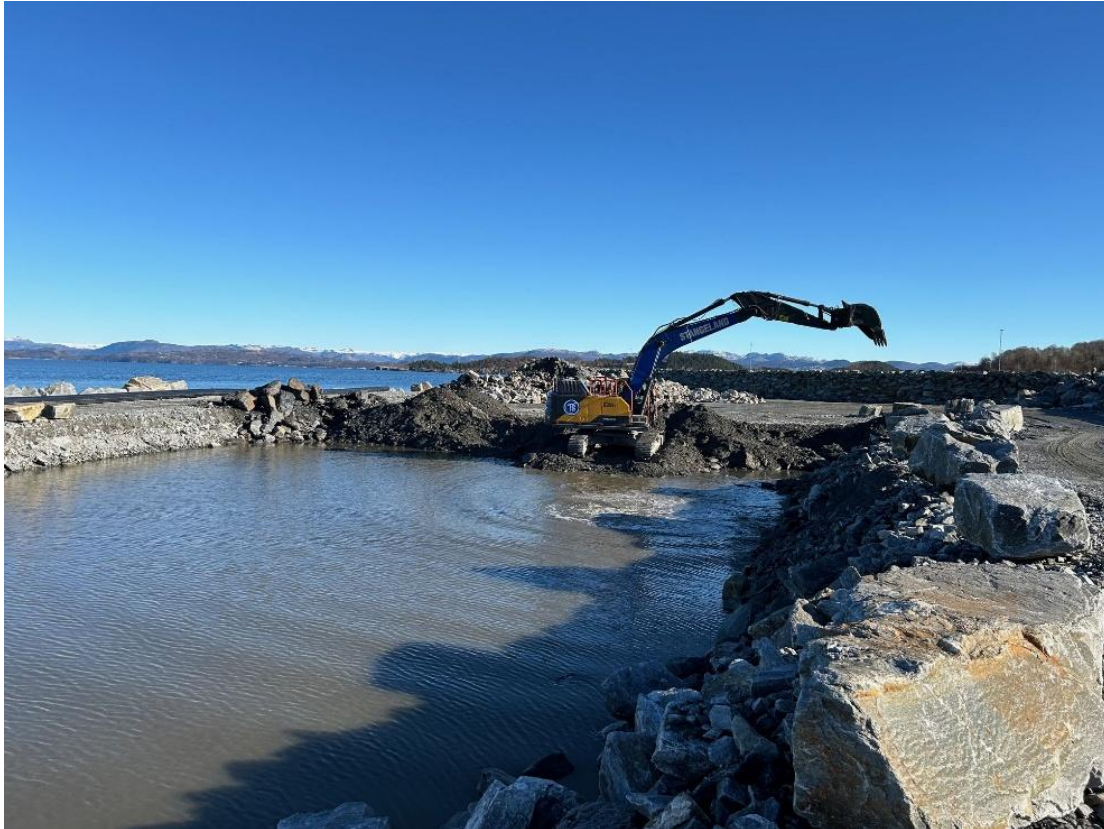
Figur 2 I pilotprosjektet var det en utfylling i en dam bak sjete.
